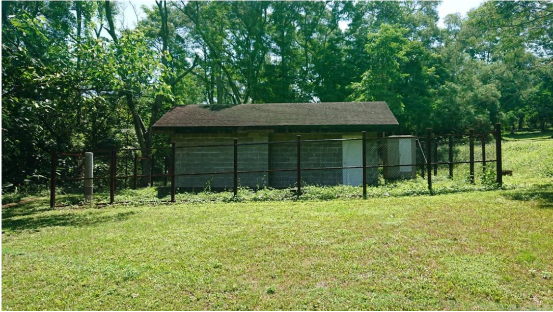
圖二十七、中正大學地磁站整修後照片。
