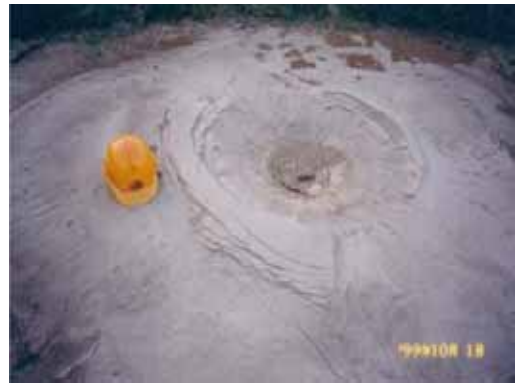
照片 B2、彰化縣伸港鄉的土壤液化現象。
