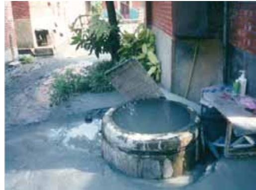
照片 B4、員林鎮員水路水井之噴沙現象。
