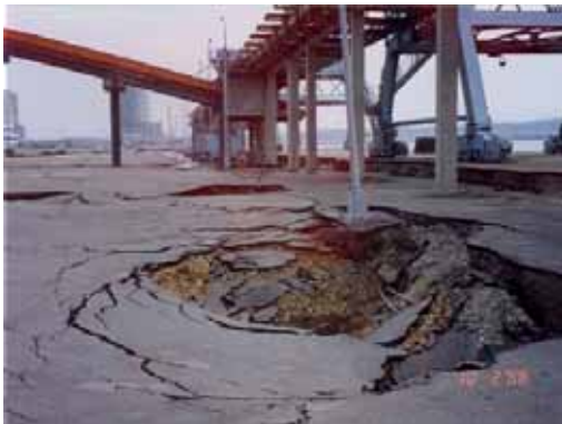
照片 B5、台中港碼頭因土壤液化而下陷。
