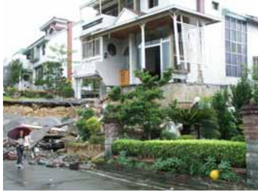
照片 A2、中台醫專前社區住宅破壞情形。
